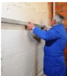
Logo após a aplicação, a massa é espalhada e alisada com régua de alumínio, tomando como referência as mestras previamente executadas; cerca de 1h a 1h 30m depois – quando a massa já iniciou o endurecimento e começa a ganhar consistência – o revestimento é novamente alisado e apertado com régua de alumínio, de forma a reduzir significativamente a fissuração na fase de secagem e aumentar a resistência mecânica.
