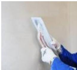
Cerca de 2 a 3h depois, quando já se encontra quase endurecido, é apertado e raspado com uma talocha metálica (liçosa), para melhor regularização e para evitar que algumas zonas fiquem “vidradas”, o que prejudicaria fortemente a aderência da camada de acabamento e a qualidade da pintura.
